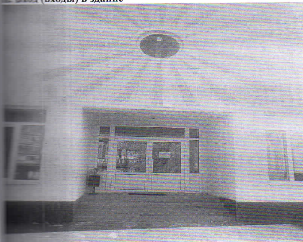
Вход (входы) в здание
