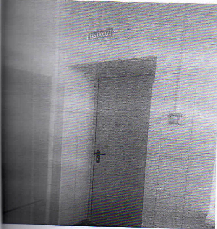
Фото . Путь эвакуации №2
