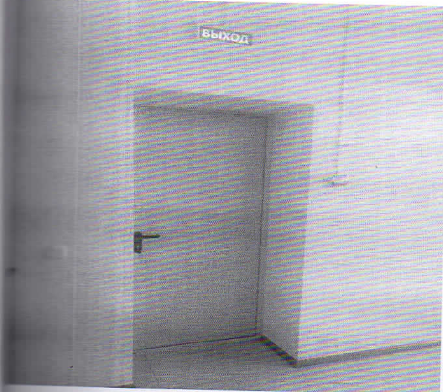
Фото . Путь эвакуации №1
