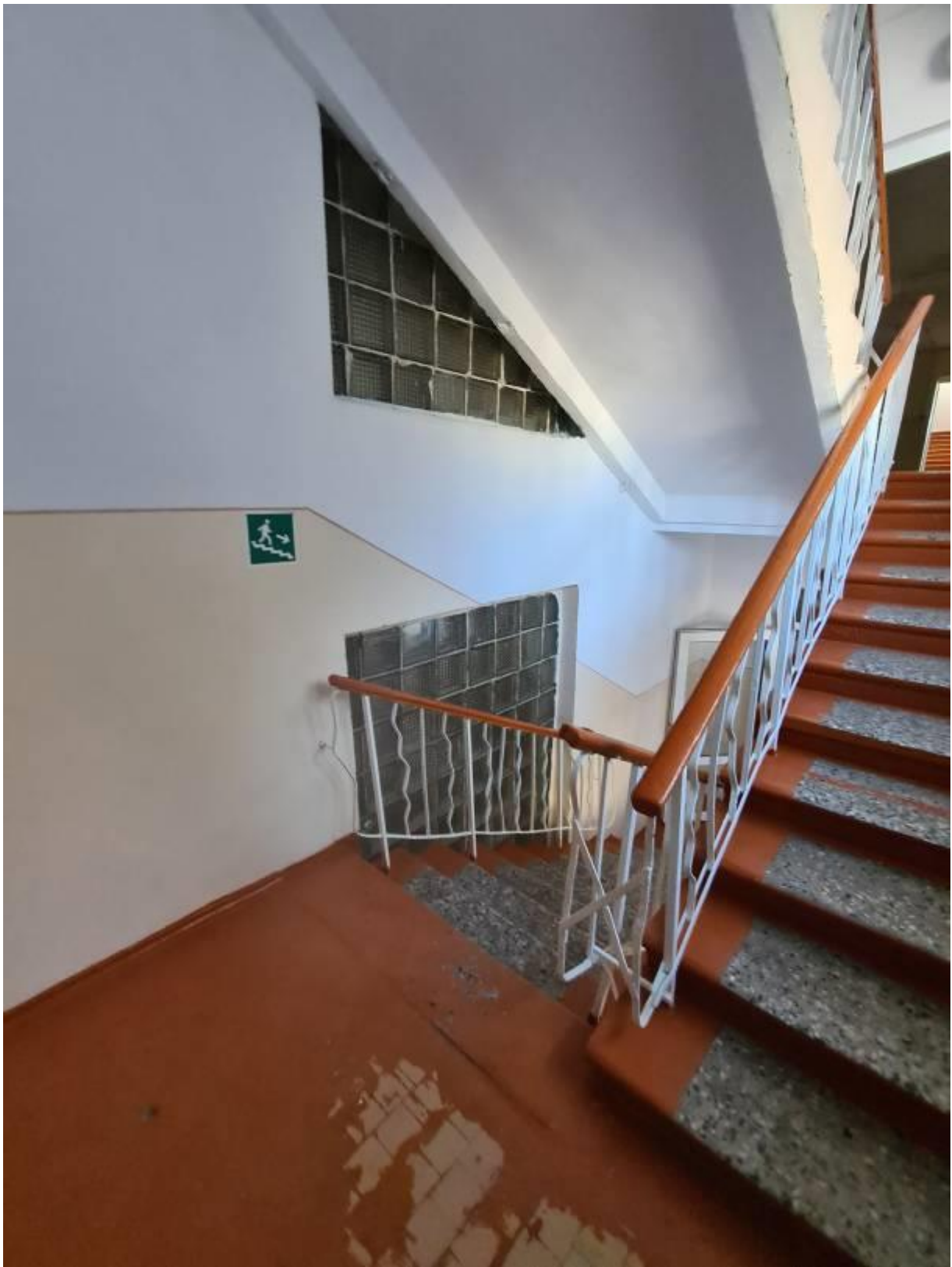
Фото 11 Лестница (внутри здания)
