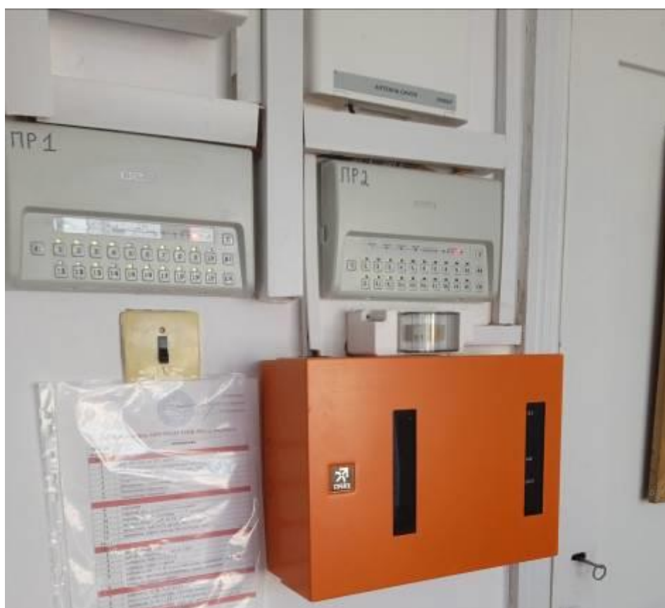
Фото 21. Пожарная сигнализация
