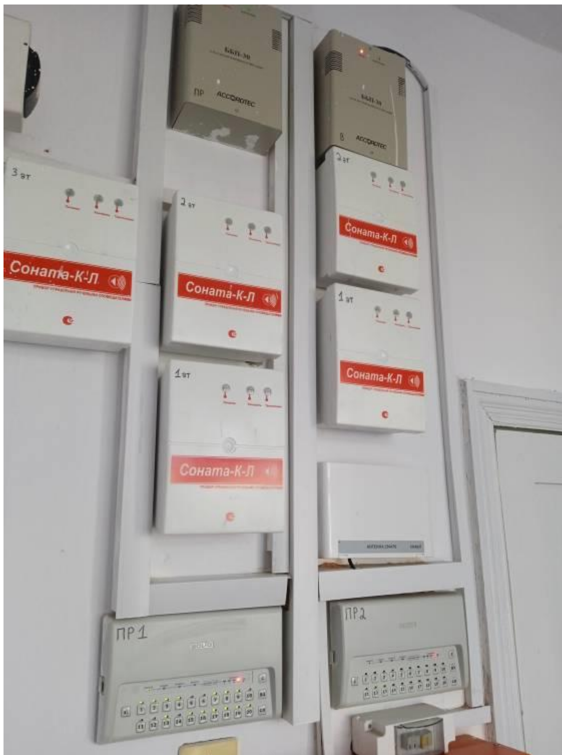
Фото 22. Пожарная сигнализация
